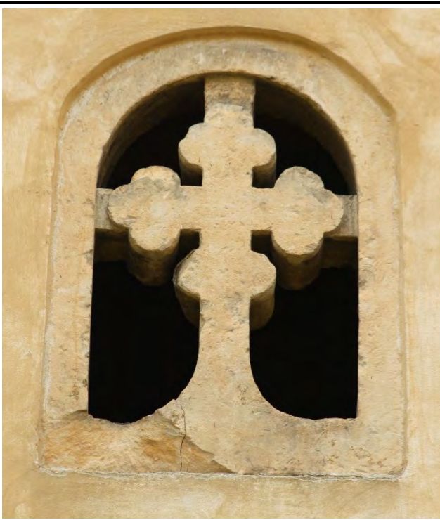
Okenní otvor jižního průčelí prvního patra věže. Foto: Jaroslav Skopec 2015.
