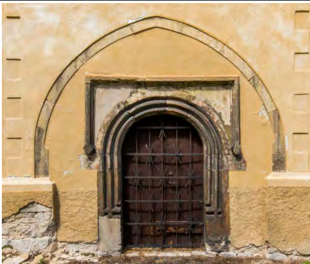
Detail vstupu přízemí předsíně v pohledu od jihu. Foto: Marta Pavlíková 2019.
