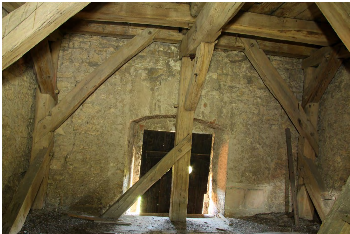
Západní stěna třetího patra věže v pohledu od východu. Patrná je štenýřová konstrukce podírající zvonovou stolicí a druhotně užitý prvek s arkádovým vlysem v první (severní) špaletě barokního okenního otvoru. Foto: Jaroslav Skopec 2015.
