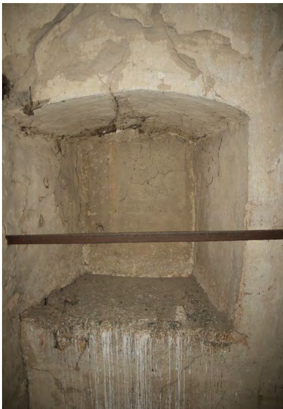
Východní zadržovaný okenní otvor jižní stěny oratoře v pohledu od severu. Foto: Jaroslav Skopec 2015.
