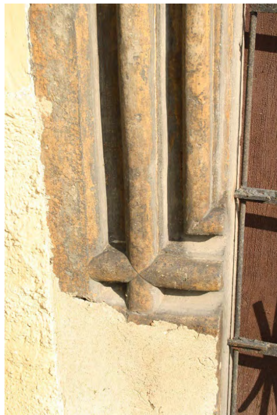
Detail ukončení profilace západní stojky jižního portálu předsíně. Foto: Jaroslav Skopec 2015.
