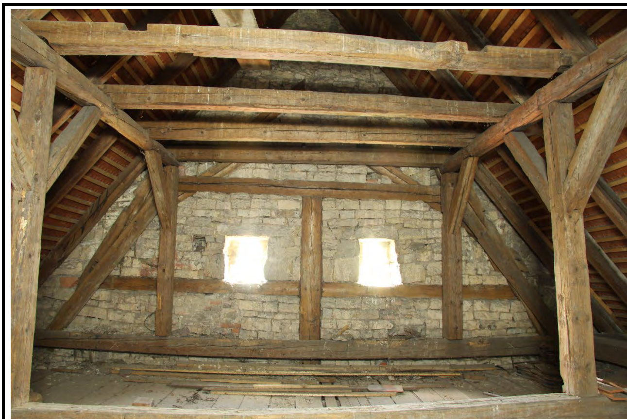
Krov nad lodí kostela v pohledu od východu s patrnou do štítu zazděnou příčnou vazbou krovu z roku 1550. Foto: Jaroslav Skopec 2015.
