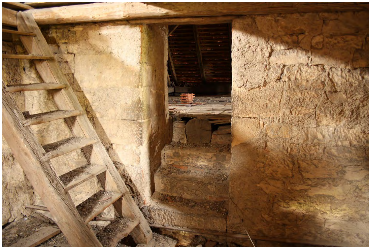
Pohled od severu na vstup z věže do krovu. Foto: Jaroslav Skopec 2015.
