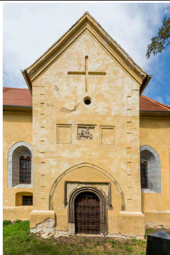
Jižní průčelí předsíně v pohledu od jihu. Foto: Marta Pavlíková 2019.
