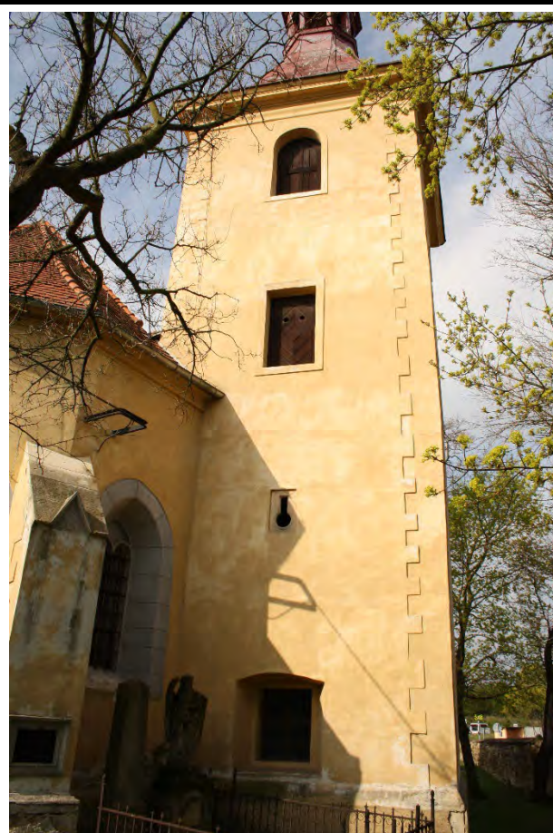
Východní průčelí věže v pohledu od východu. Foto: Marta Pavlíková 2019.
