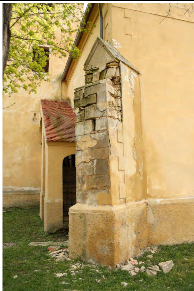
Severozápadní nároží lodi s opěrným pilířem v pohledu od severozápadu. Foto: Marta Pavlíková 2019.
