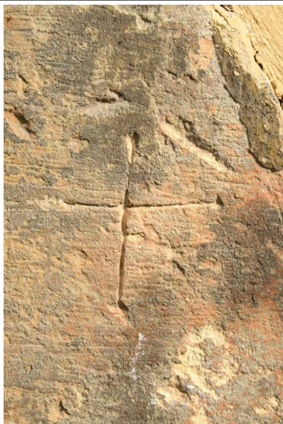
Detail kříže na východní stojce portálu předsíně. Foto: Jaroslav Skopec 2015.
