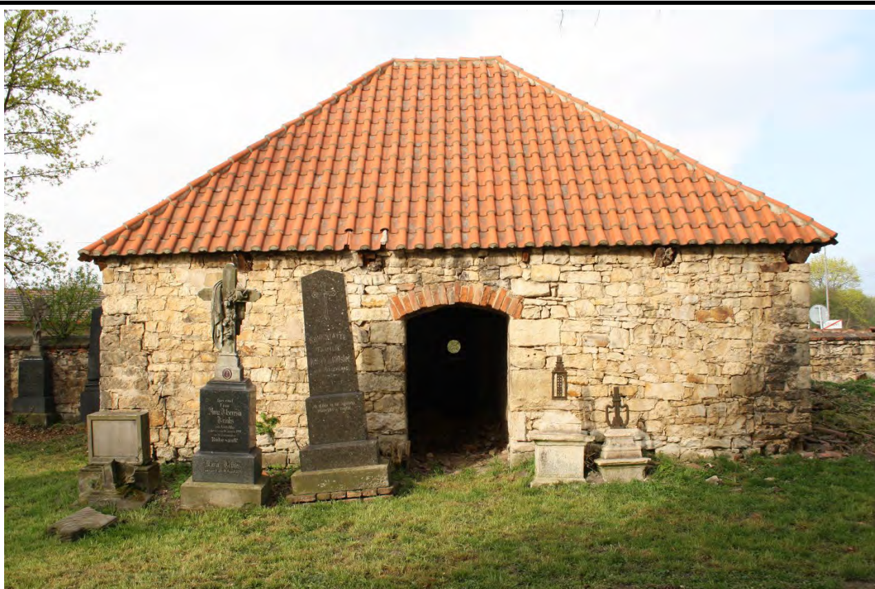
Východní průčelí kostnice v pohledu od východu. Foto: Jaroslav Skopec 2015.
