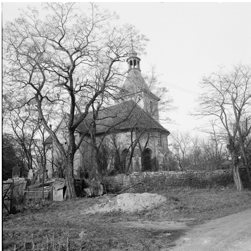
Celkový pohled od jihovýchodu. Foto: 1987, sbírka negativů NPÚ ÚOP v Ústí n. L., sign. 4478.
