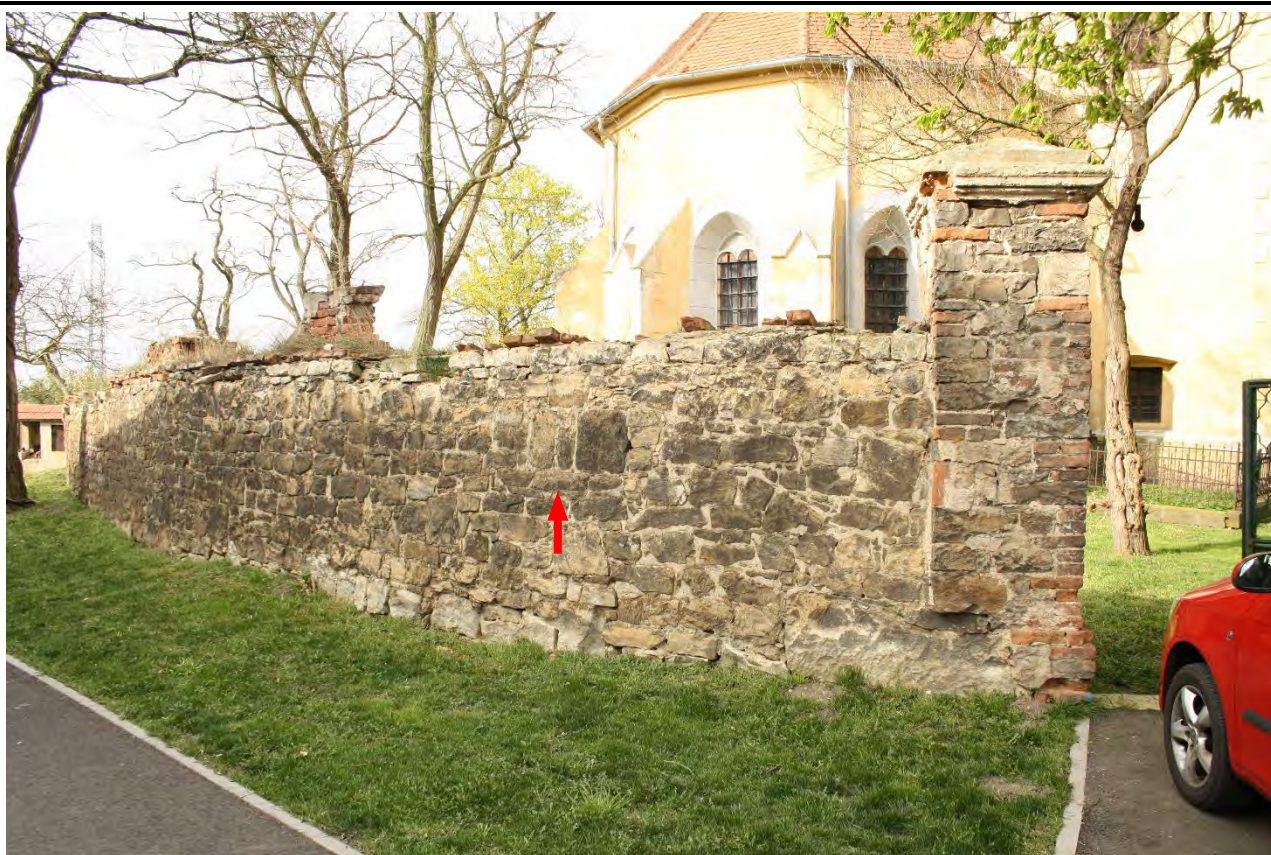
Východní úsek hřbitovní zdi ze 16. století v pohledu od východu. Šipka vyznačuje polohu štěrbinového otvoru. Foto: Jaroslav Skopec 2015.
