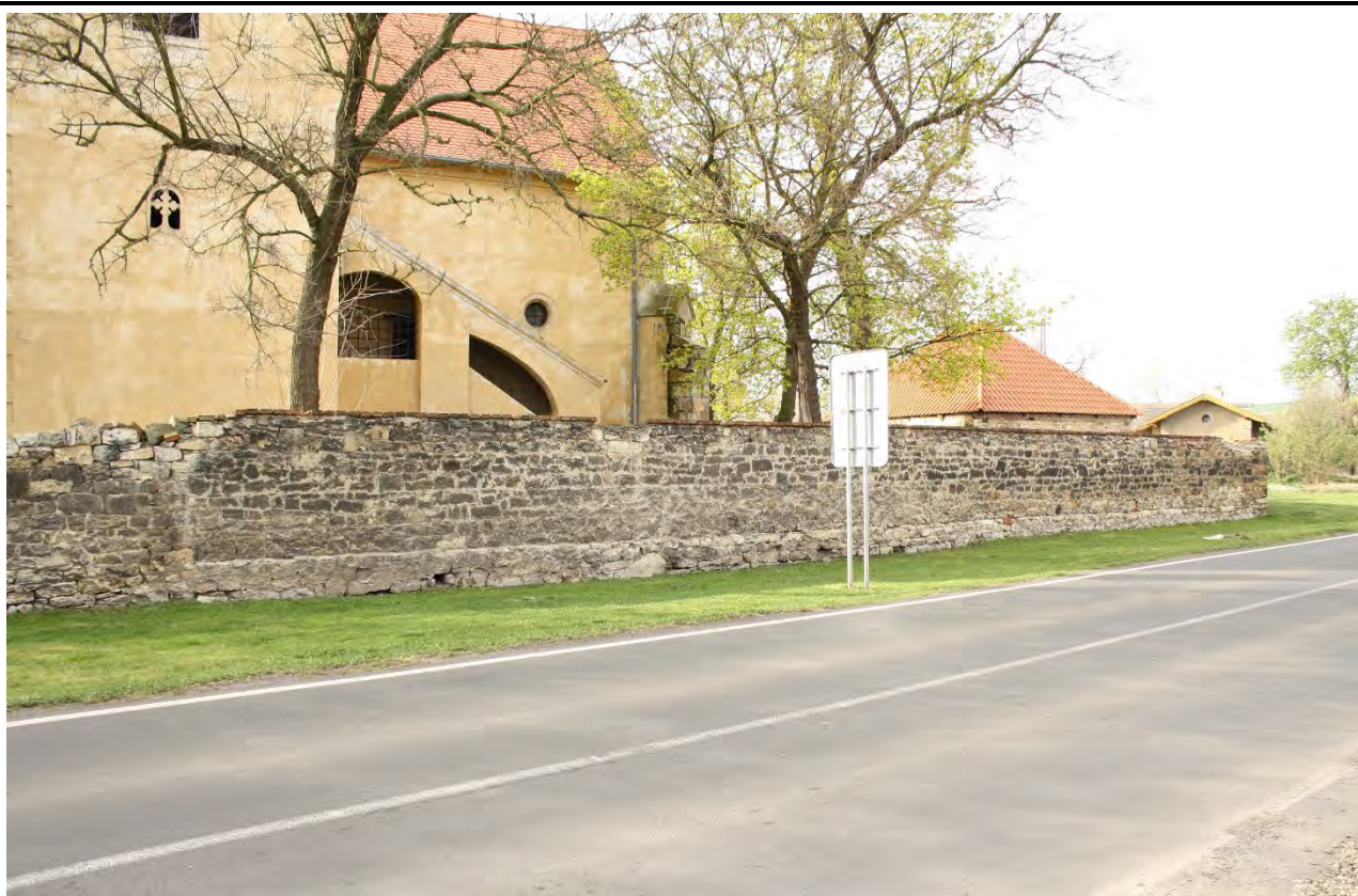
Hřbitovní zeď v pohledu od severu. Vlevo je patrné rozhraní mezi úsekem zdiva ze 16. století (vlevo) a rozšířenou částí z roku 1860. Foto: Jaroslav Skopec 2015.
