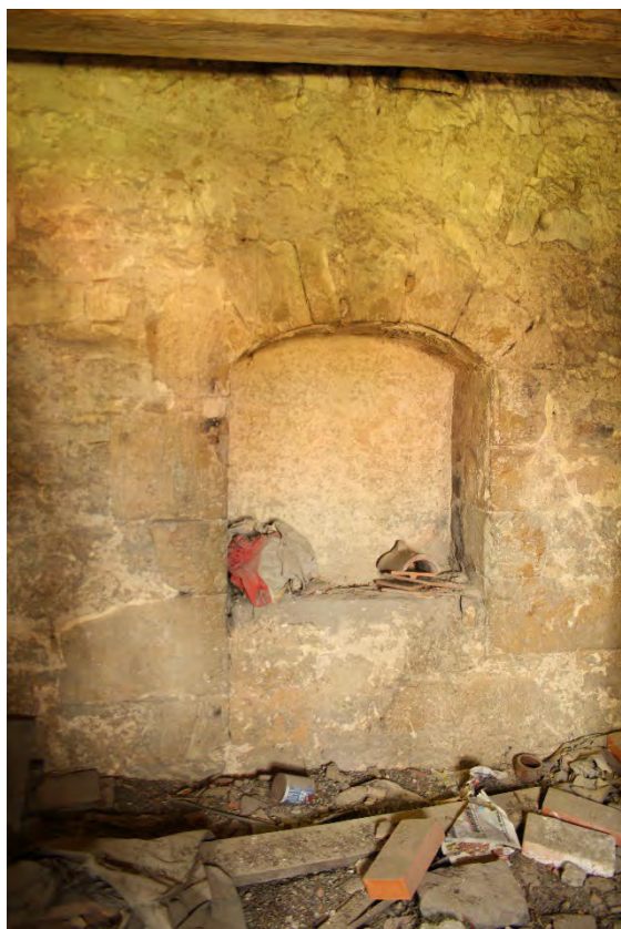
Nika někdejšího vstupu z kostela do prvního patra věže v pohledu od severu. Foto: Jaroslav Skopec 2015.
