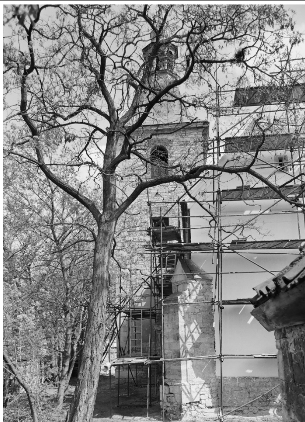
Severní část západního průčelí v pohledu od západu. Foto: 2004, sbírka negativů NPÚ ÚOP v Ústí n. L., sign. 155540.
