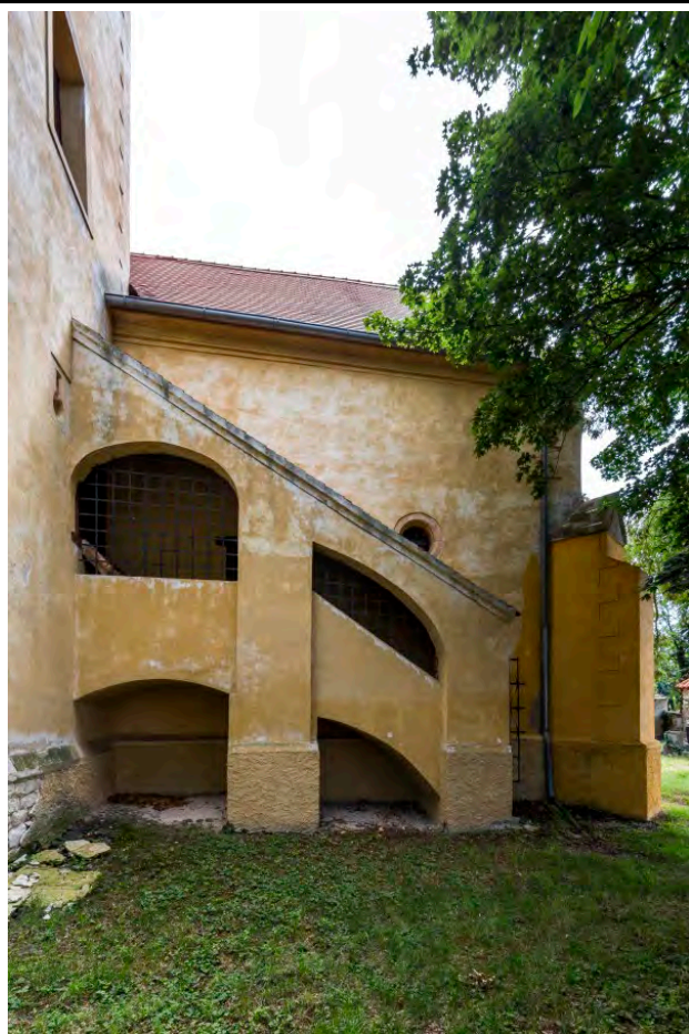
Severní průčelí lodi v pohledu od severu. Foto: Marta Pavlíková 2019.
