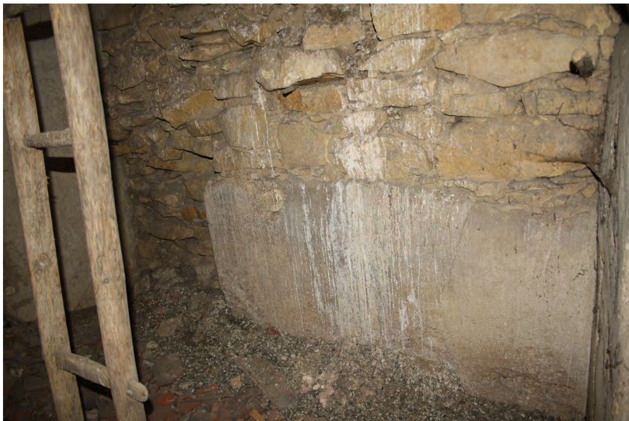
Spodní polovina zadržovaného arkádového otvoru oratoře v pohledu od jihovýchodu s patrnou zděnou poprsní zídou. Foto: Jaroslav Skopec 2015.
