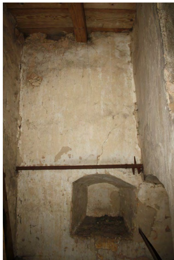
Východní stěna oratoře v pohledu od západu. Foto: Jaroslav Skopec 2015.
