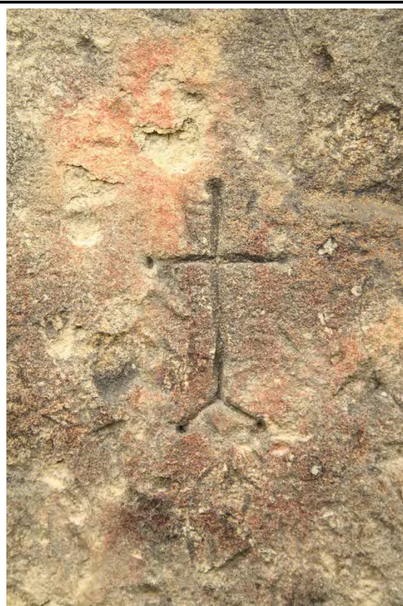
Detail kamenické značky na nárožním armovacím kvádru západního průčelí kostnice. Foto: Jaroslav Skopec 2015.
