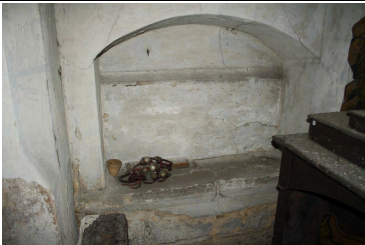
Východní nika předsíně v pohledu od severozápadu s původně exteriérovým soklem v zadní stěně. Foto: Jaroslav Skopec 2015.
