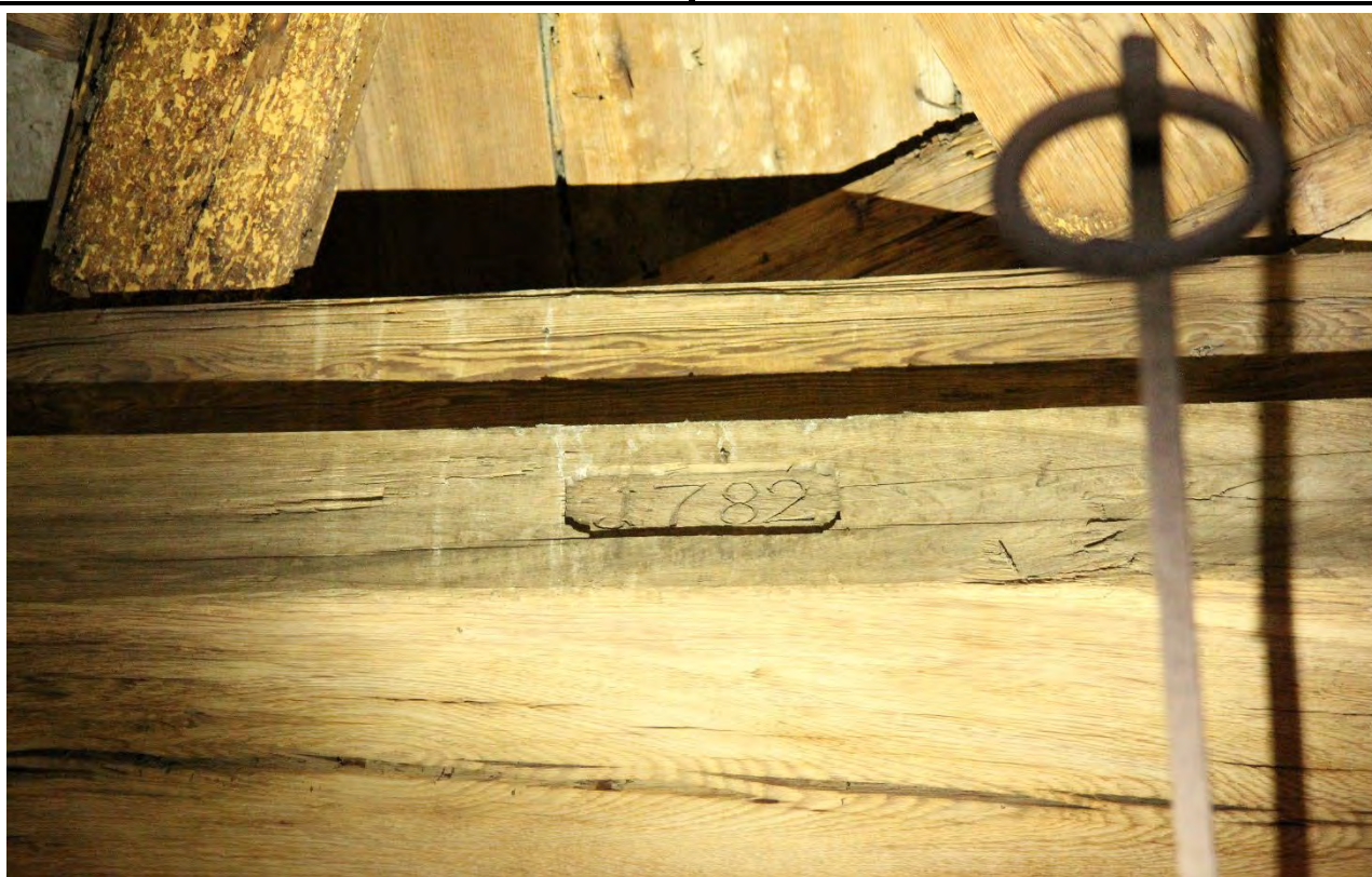
Detail datace zvonové stolice. Foto: Jaroslav Skopec 2015.
