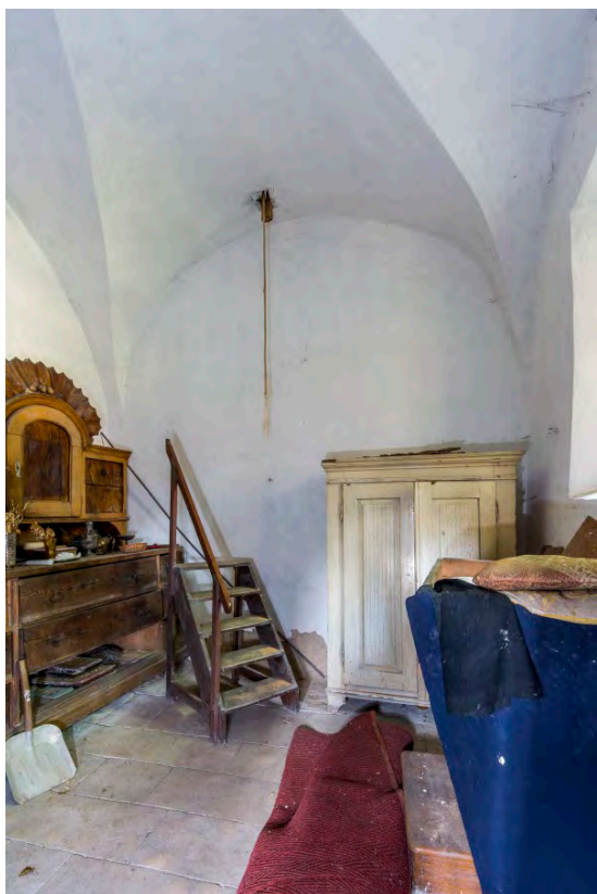
Severní stěna v pohledu od jihu. Foto: Marta Pavlíková 2019.
