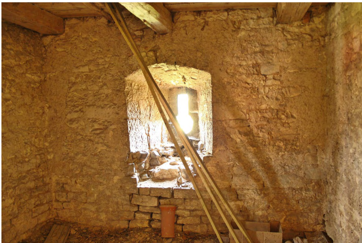
Východní strana prvního patra věže s okenním otvorem ve tvaru tzv. klíčové střílny. Foto: Jaroslav Skopec 2015.
