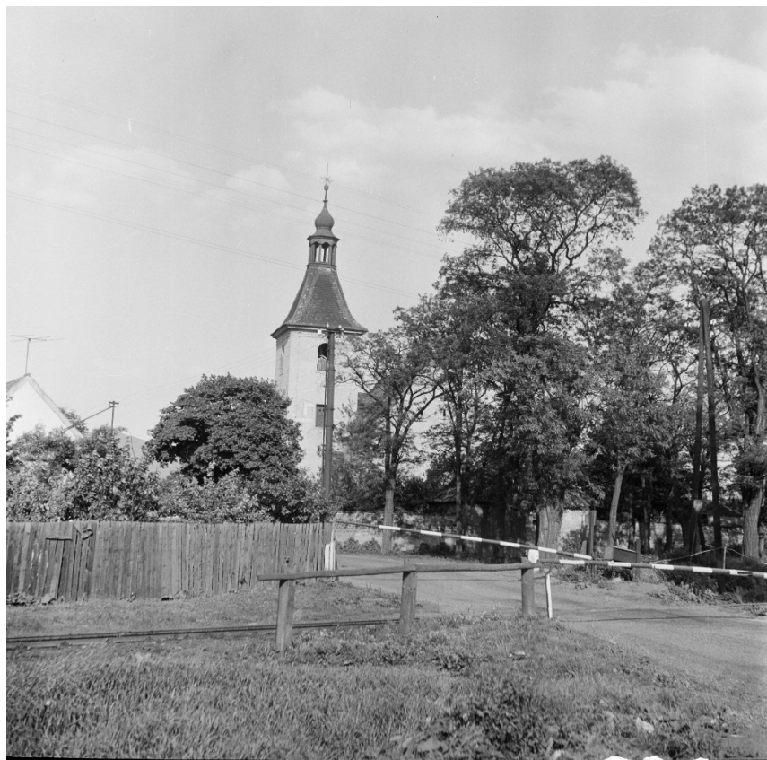
Celkový pohled od západu. Foto: 1963, sbírka negativů NPÚ ÚOP v Ústí n. L., sign. 9236.
