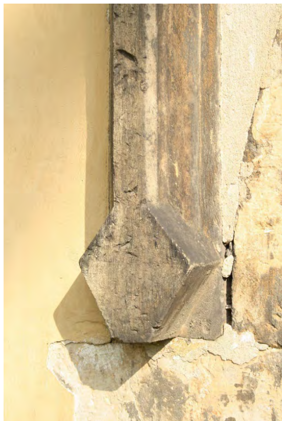
Detail západního ukončení římsového orámování portálu předsíně. Foto: Jaroslav Skopec 2015.
